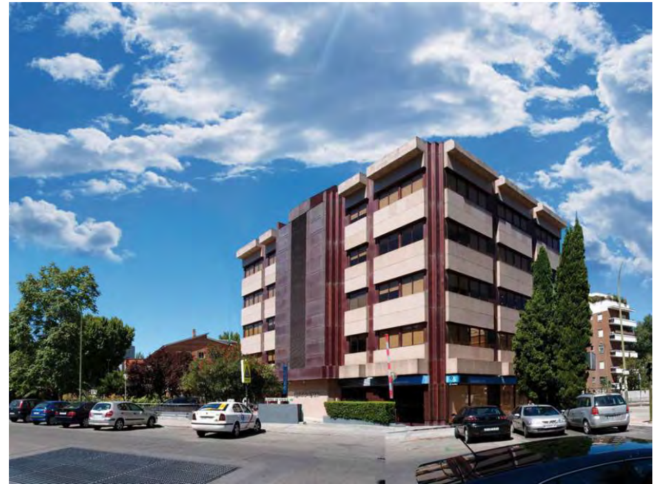
PROYECTO: FITENI I. Remodelación integral de edificio de oficinas en calle López de Houos. Madrid EDIFICABILIDAD: 2.161 m 2 UNIDADES: N/A AÑO: 2017
