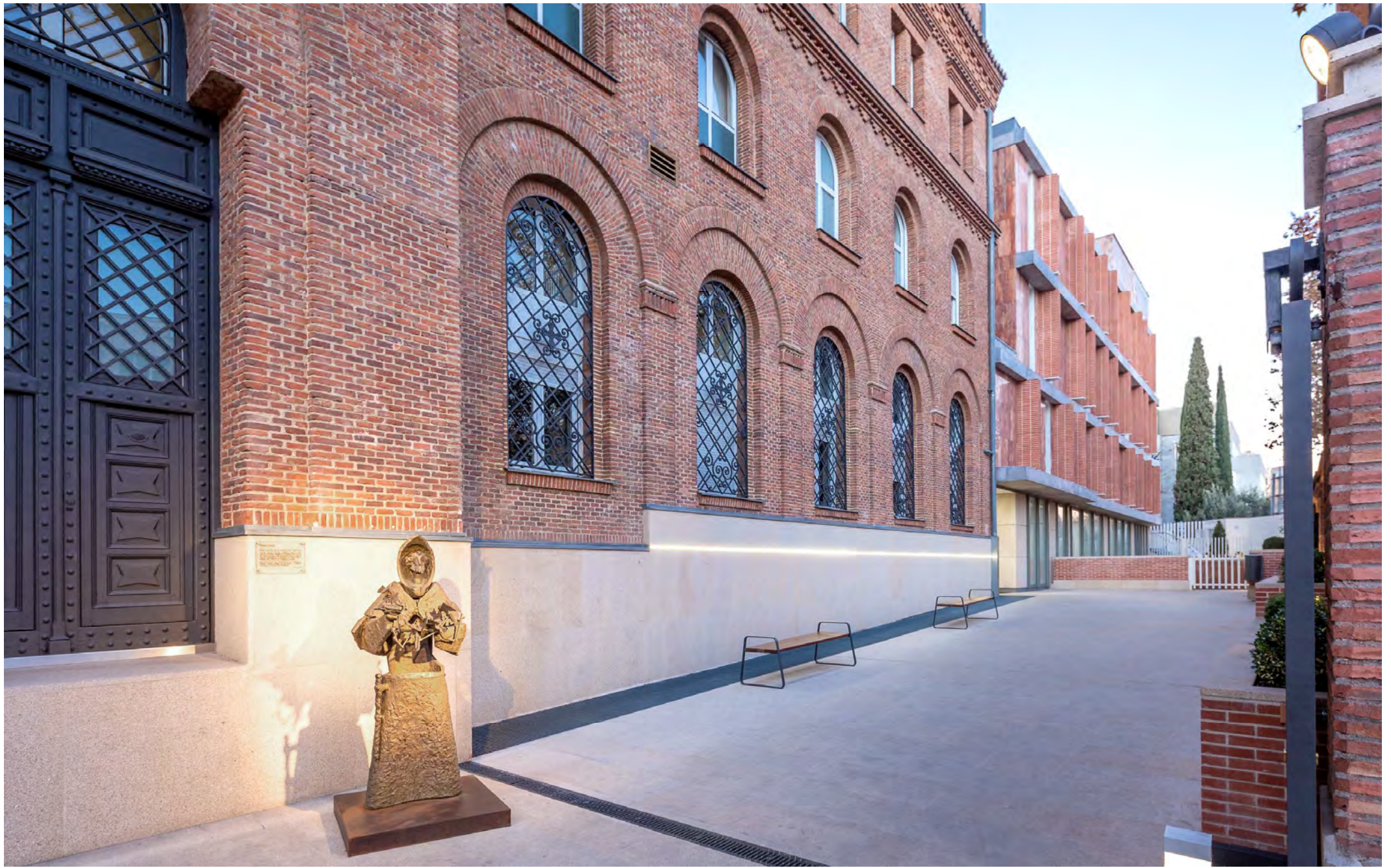
Reforma y Ampliación del Hospital San Francisco de Asís, Madrid Cliente: Instituto de las Franciscanas Misioneras de María
