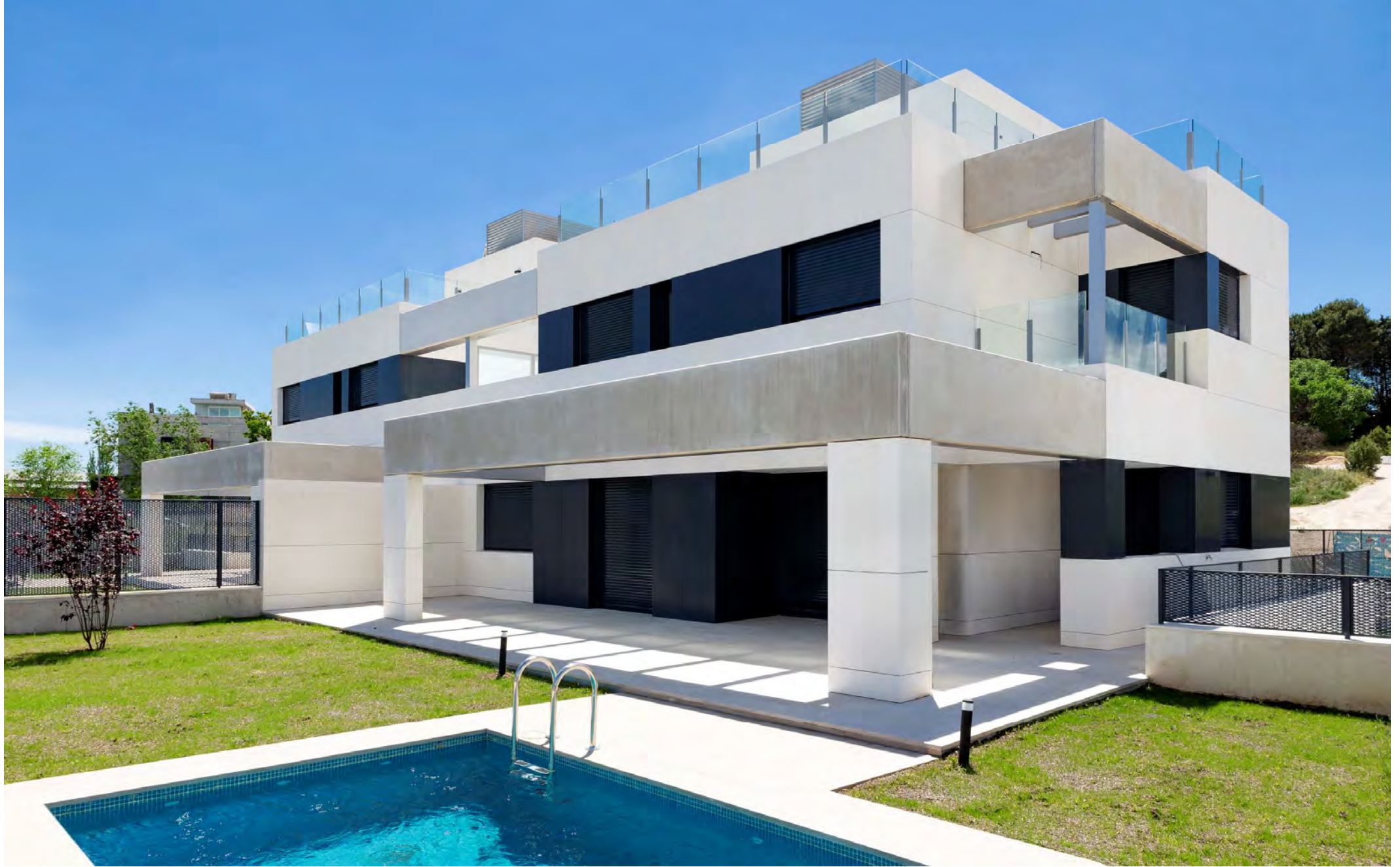
Célere Grace. 10 Viviendas Unifamiliares en Aravaca. Madrid. Cliente: Vía Célere
